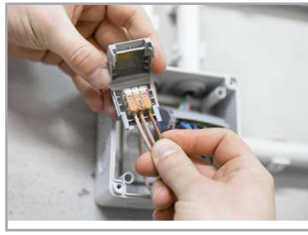
Verdrahtete Klemme in die Gelbox einlegen.
