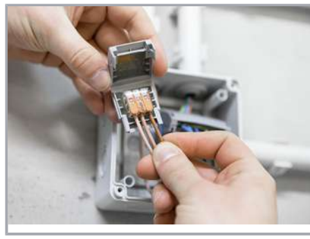
Verdrahtete Klemme in die Gelbox einlegen.
