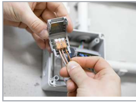
Verdrahtete Klemme in die Gelbox einlegen.
