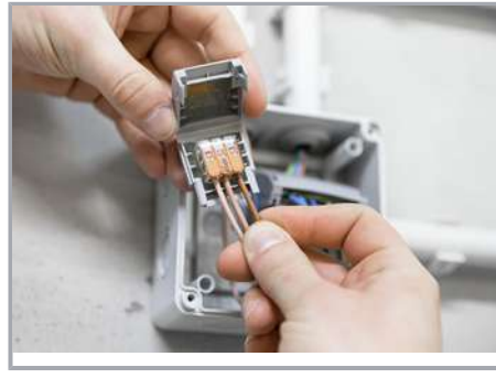
Verdrahtete Klemme in die Gelbox einlegen.
