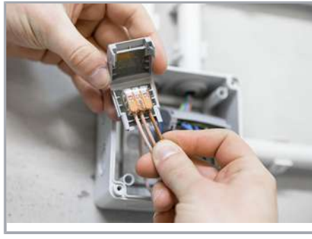
Verdrahtete Klemme in die Gelbox einlegen.
