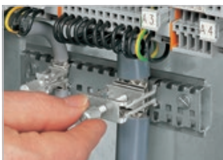
Затяжка/удаление зажима для экрана.
