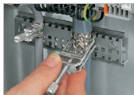
Для удаления зажима, отвинтите винт до освобожде- ния храпового механизма, затем немного потяните зажим и снимите его.
