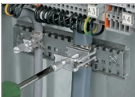
После соединения необходимо затянуть крепежный винт для завершения установки. Рекомендуемый момент затяжки: 0,5 Нм
