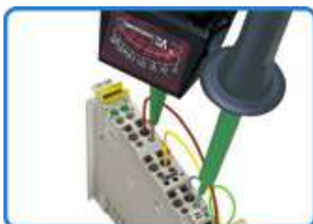
Проверка прохождения сигнала при подсоединенных проводниках
