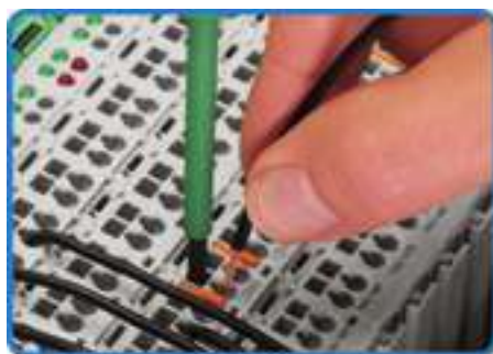
Пример монтажа проводов, система WAGO-I/O-SYSTEM 750
