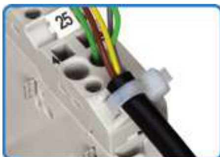
Закрепление кабеля на разъеме
