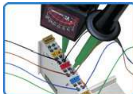
Проверка прохождения сигнала при подсоединенных проводниках
