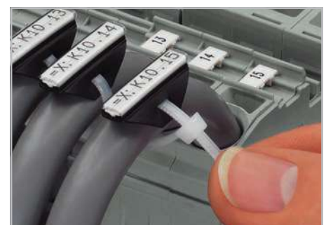
Прикрепите маркировочную манжету (211-129) к отдельным кабелям или проводникам при помощи кабельных стяжек (807-090/101-100).
